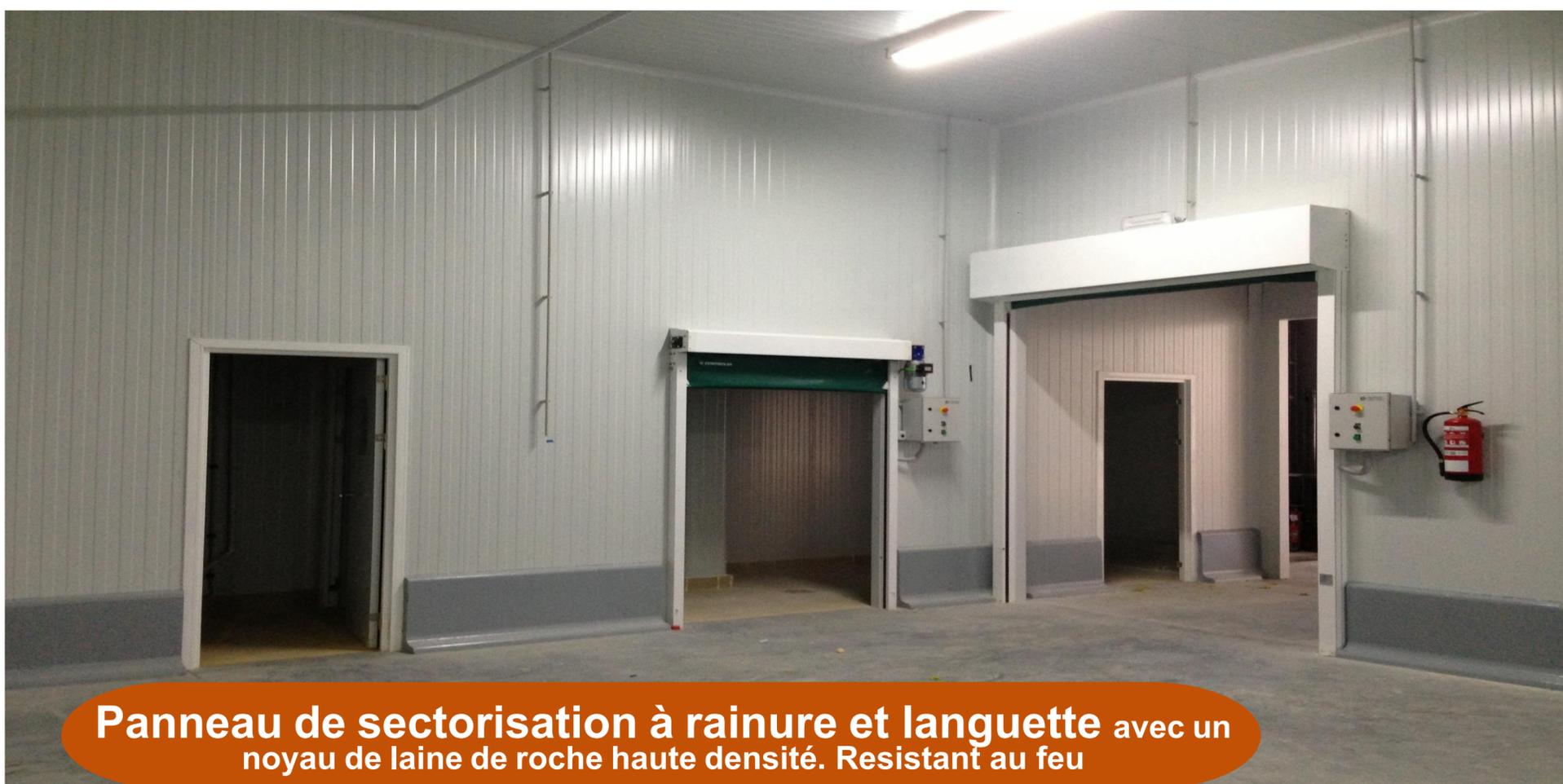
**Panneau de sectorisation à rainure et languette avec un noyau de laine de roche haute densité. Résistant au feu**
